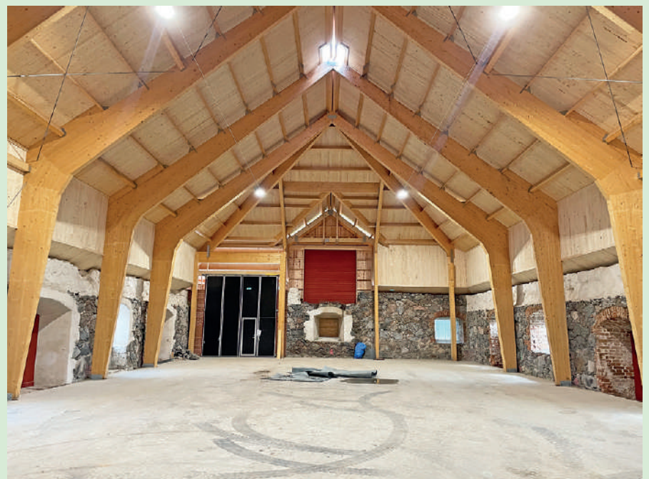
Ladugården efter renoveringen.
