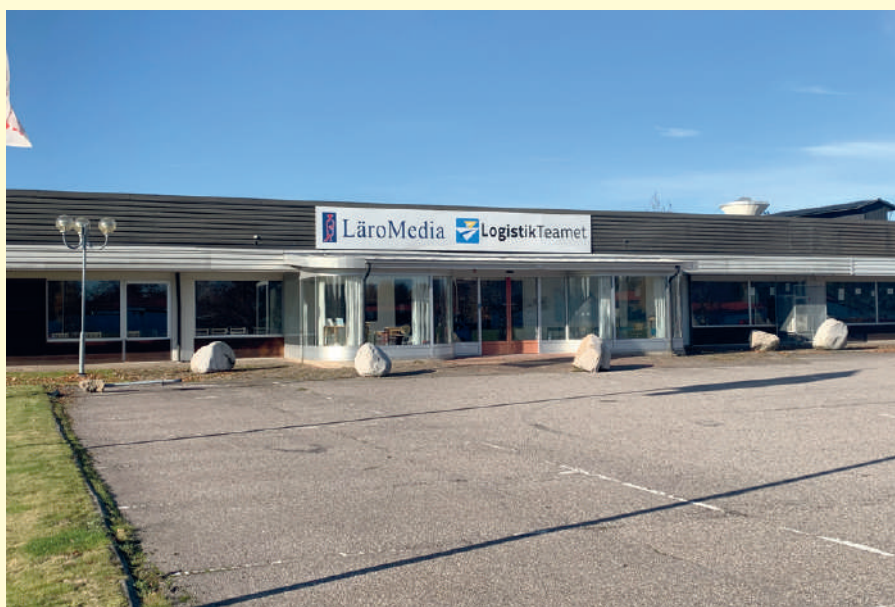
Nya skyltar på nymålade fasad.
