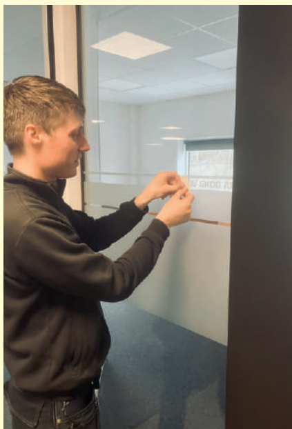
Här monterar Mattias vinyl på fönster inomhus. Foto: Sven Söderlund.
