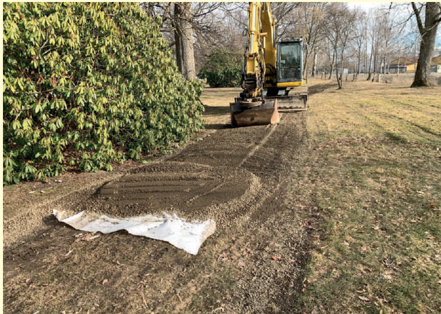
Grusningen av norra Kanalpromenaden är påbörjad.
