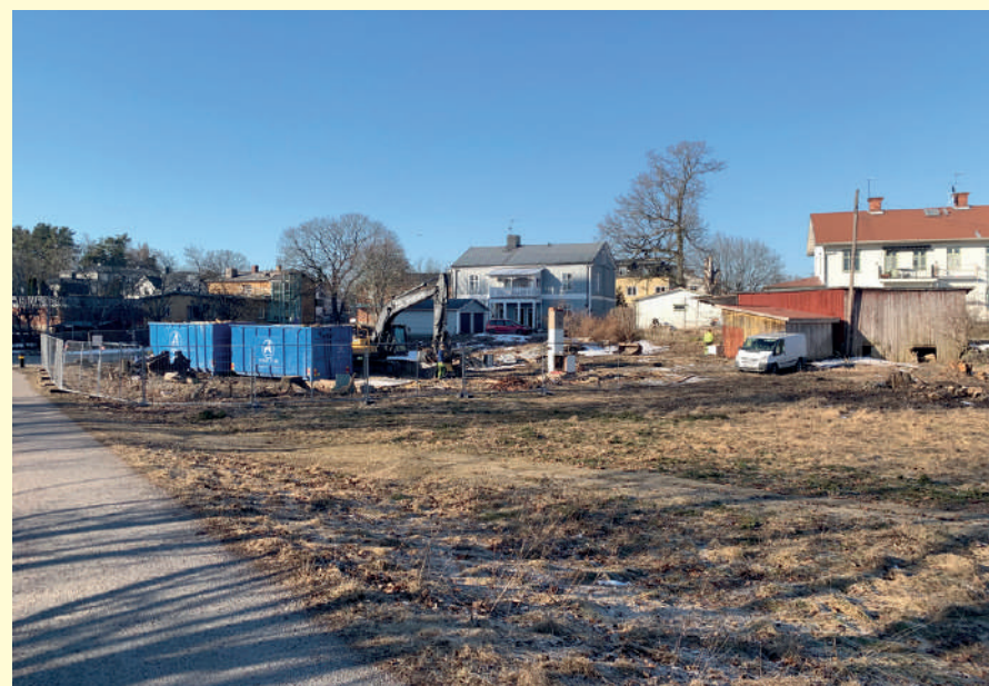
Röjning av den gamla ödetomten vid Industrivägen påbörjades förra veckan.
