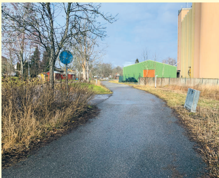
På gång- och cykelvägen utmed Marknadsvägen kommer gatubelysningen förbättras i höjd med vändplatsen. Två nya belysningsstolpar skall sättas upp på platsen.
