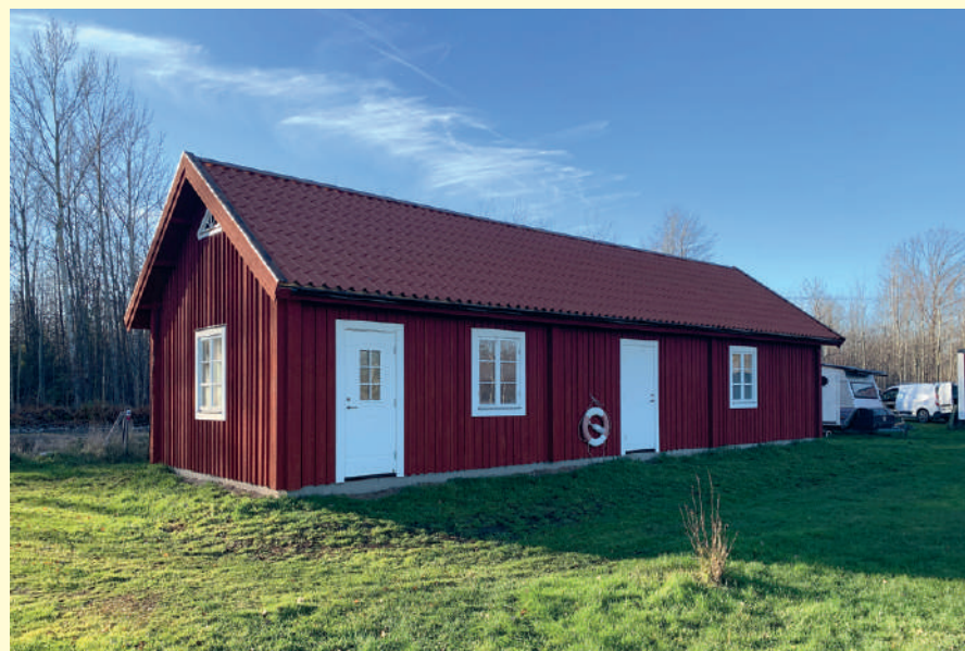
Den nya bageri- och butiksbyggnaden sett från baksidan där det skall bli trädgårdscafé.
