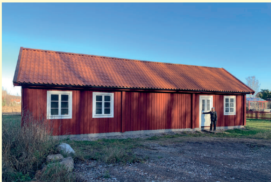
Den nya bageri- och butiksbyggnaden med blivande parkeringsplatser sett från framsidan.
